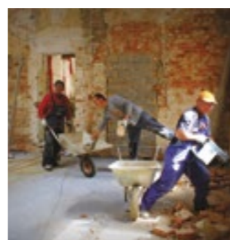
Trwają prace przy ul. Leśnej w Trzebnicy w przyszłości powstanie tam Punkt Porad Obywatelskich oraz Inkubator Przedsiębiorczości.
