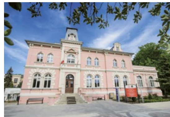
Odrestaurowany budynek Starostwa Powiatowego w Trzebnicy przy ulicy Leśnej
